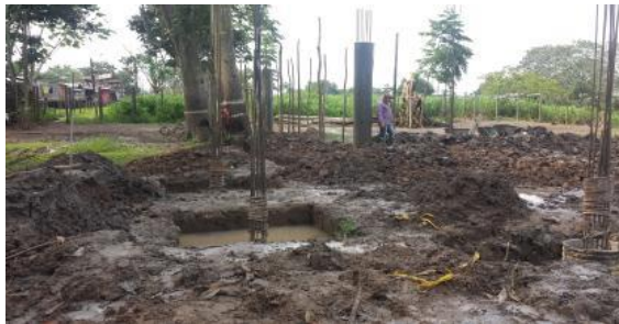
Foto 13: Cimentación y refuerzo columnas Mirador N° 2
